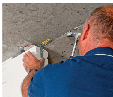
Co drugą płytę mocuje się przy pomocy kotwy sprężystej do sufitu.
