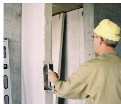
Płyty łączy się spoiną pionową.
