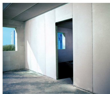
Powierzchnia ścian gotowa jest do tapetowania lub cienkowarstwowego wykończenia.
