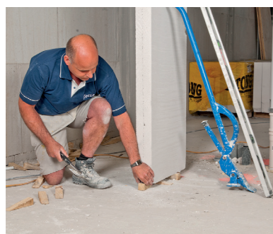
Ustawienie koryguje się przy pomocy drewnianych klinów i podnośnika ręcznego.
