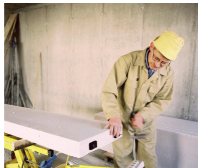
Do płyt montuje się gumowe bloki, zapewniające dylatację od stropu.
