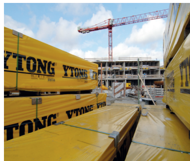
Płyty umieszczane są w budynku na etapie wznoszenia ścian nośnych.
